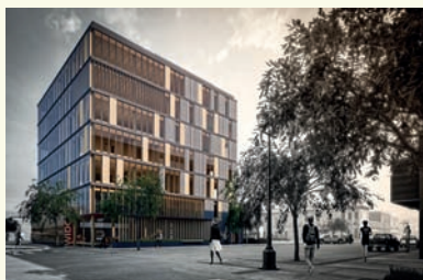
卑诗省某大学土木系学院楼
