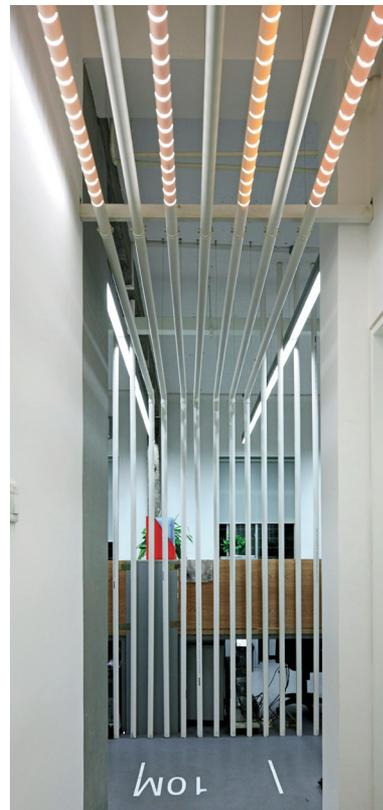
工作室灯具：用 PVC 的下水管制作，它的接头、固定都是很工业化的东西。最开始只是准备用普通的灯管照明，后来工人切 PVC 管的时候，有一截废料上刚好有拿砂轮锯的缺口，我一看这个缺口在砂轮的加工下非常圆润，根本不需要细加工，立刻就修改了设计，把整个 PVC 的下水管直接切出排列整齐的若干缝隙，灯管穿进去，光线均匀地透出来（图 8）。
