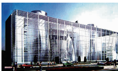
图14 北京天文馆，大量双弯中空夹胶点支承玻璃
