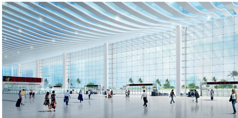
图94 深圳北站总面积超过2万 \text{m}^2 的索网幕墙
