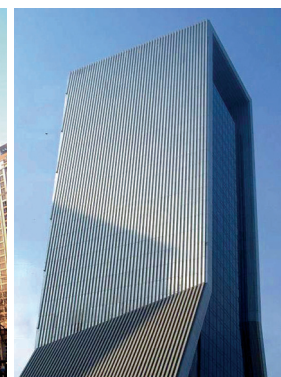
图74 电视文化中心钛锌板幕墙
