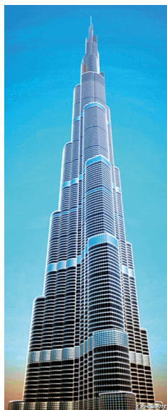
图45 迪拜哈里法塔, 高度828m, 建筑幕墙13万m 2
