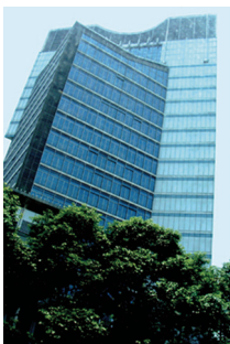
图109 都江堰(9度地震区)玻璃幕墙完好无损
