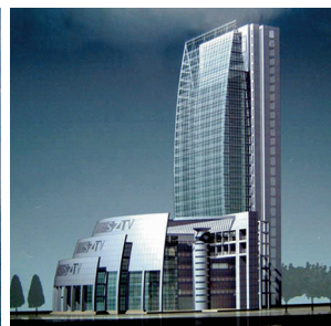
图99 深圳电视中心，透镜形点支式双层通风幕墙（左）和热通道（右）
