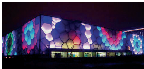
图35 水立方, ETFE 薄膜气枕式幕墙
