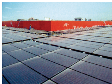
图102 上海世博会中国馆，3 000 \text{m}^2 光伏屋面
