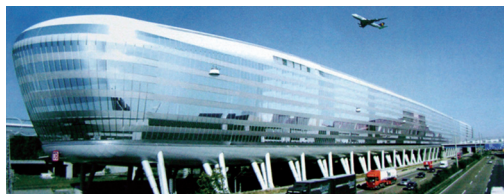
图43 法兰克福机场的铁路车站幕墙工程
