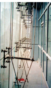
图99 深圳电视中心，透镜形点支式双层通风幕墙（左）和热通道（右）
