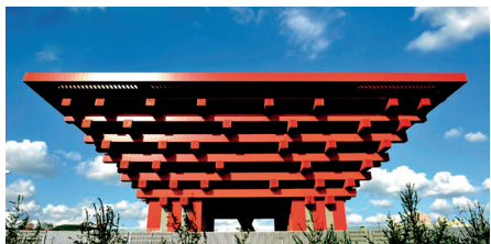
图31 上海世博会中国馆, 中国红条纹铝蜂窝板
