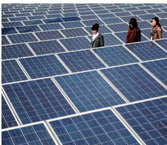
图101 江西新余，500kW 光伏屋面
