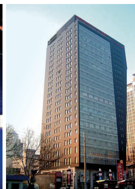
图73 北京天恒大厦真空玻璃幕墙
