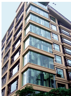
图110 青城山(9度地震区)幕墙完好无损
