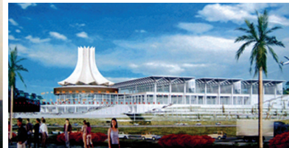
图13 南宁国际会展中心，采用了大面积明框幕墙和张拉膜采光顶
