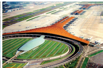
图39 首都机场T3航站楼, 屋面30万 \text{m}^2
