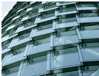
图53 深圳新世界中心点支玻璃盒子, 钢爪有7个支承头
