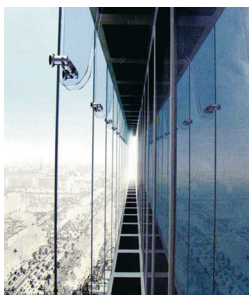
图98 热通道：武汉精纶办公楼
