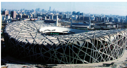
图36 北京奥运会主运动场——鸟巢, ETFE和PVC薄膜屋面
