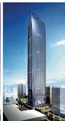
图23 深圳京基大厦，441m
