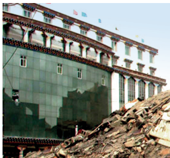
图112 玉树隐框幕墙完整
