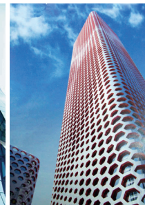
图61 天津中钢大厦立体蜂窝形外墙
