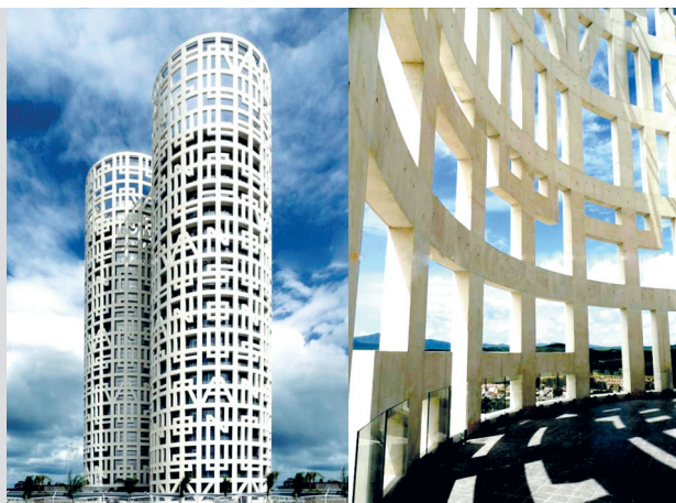
西班牙太阳塔的空间刚架支承系统
