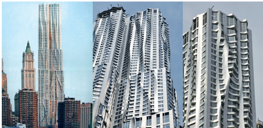
图26 纽约比克曼大厦波浪形起伏的不锈钢幕墙
