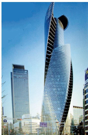
图42 名古屋站前大厦双层幕墙
