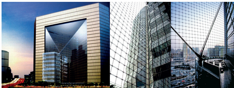
图16 北京新保利大厦索网结构支承玻璃幕墙
