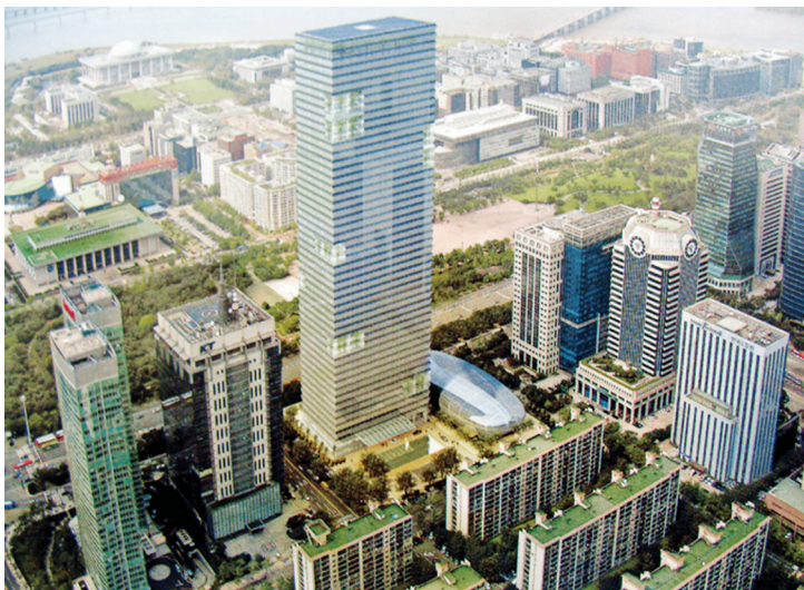
图54 首尔韩国行业总会办公楼，墙面和屋面均安装光伏组件
