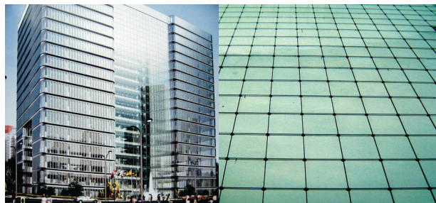
图17 北京中关村文化商厦，索网70mX29m，横索34mm，竖索24mm
