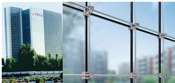
图18 克拉玛依石油指挥中心，索网90mX22m，位于山口，风荷载标准值高达 0.95\text{kN/m}^2
