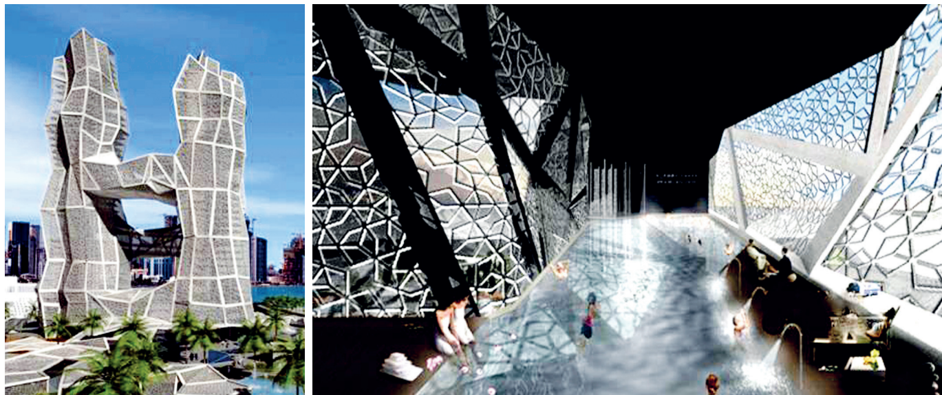
图12 迪拜阿尔法塔幕墙由空间刚架支承
