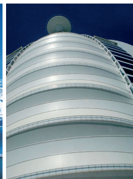
图40 膜材紧绷在水平钢结构上
