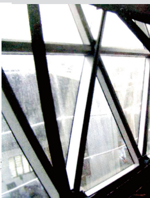
卡塔尔多哈, 阿尔比达塔, 三向杆系结构
