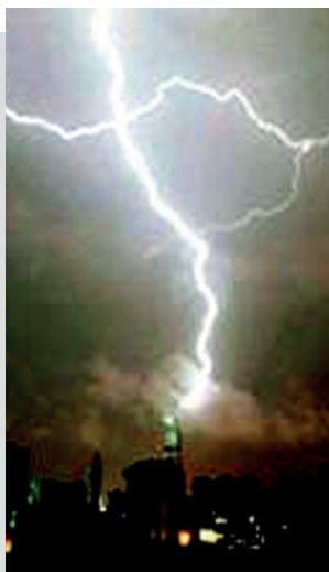
深圳京基大厦，445m（2011.5）
