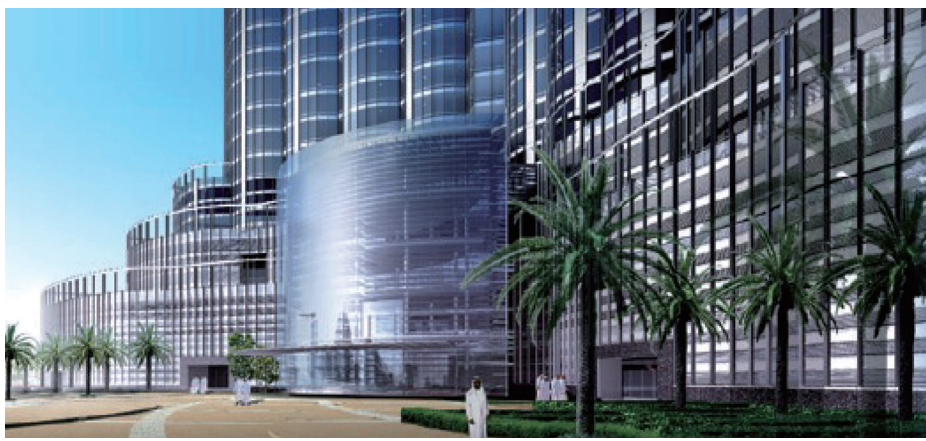
图28 大厅双圆柱外形双层通风幕墙
