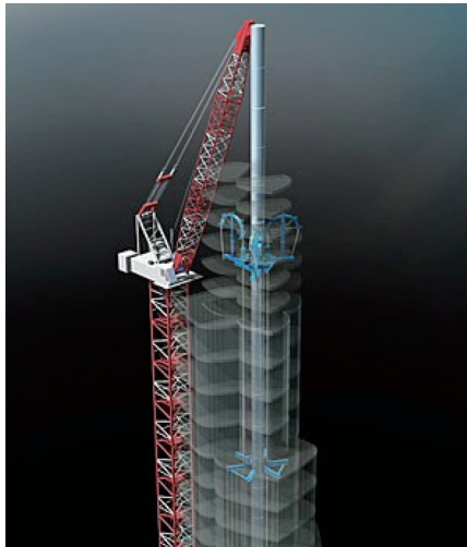
图3 顶部可升高的钢桅杆
