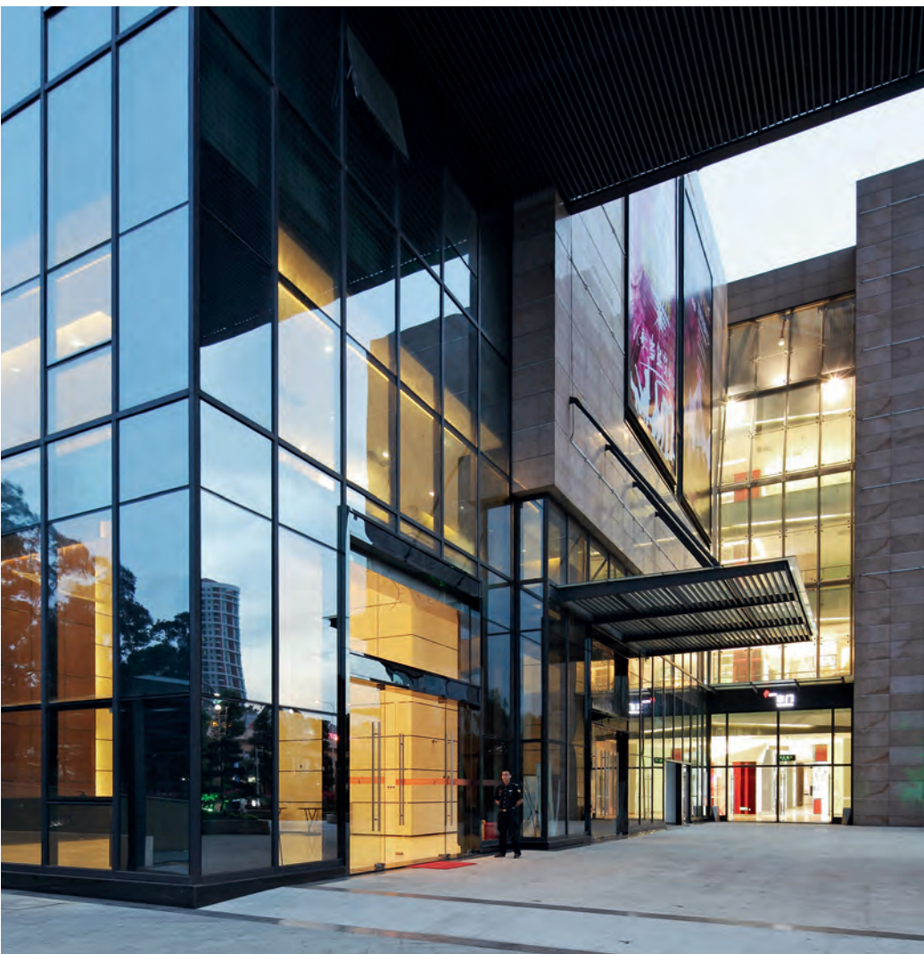
办公楼出入口
