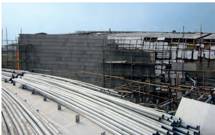
大同博物馆现场施工（远大幕墙提供）
