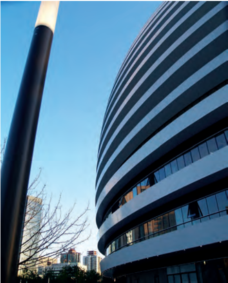
银河SOHO实景照片
