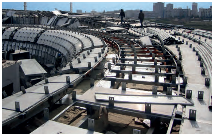
大同博物馆幕墙保温、铝扣板防水（远大幕墙提供）
