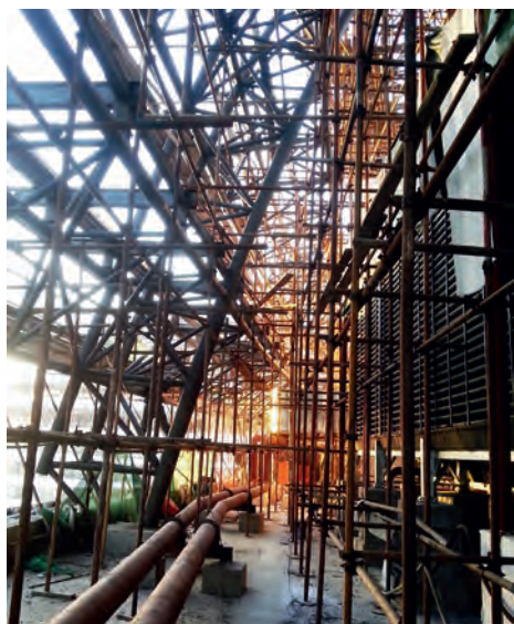
望京SOHO钢结构与屋顶设备
