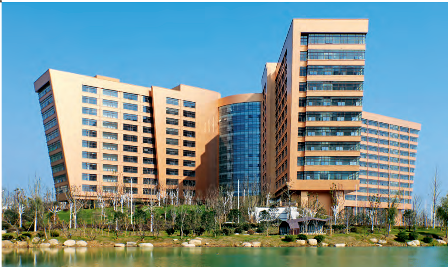
中国科学技术大学先进技术研究院综合楼西南立面
