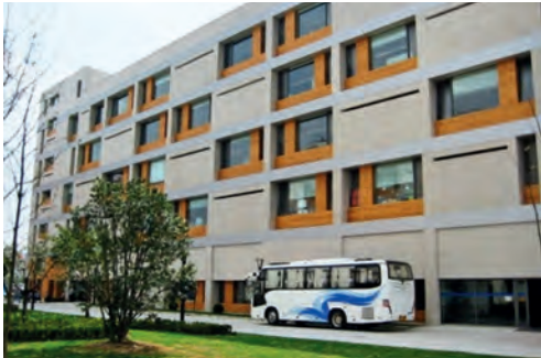
上海南洋国际学校 (水泥纤维板幕墙)
