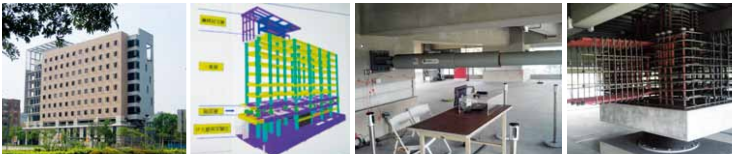
图2 台大土木研究大楼
