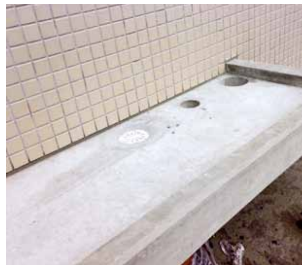
图10 万科金色里程A轴预制板装配图
