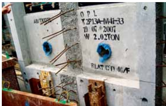
图1 香港PC工程现场照片-大角咀住宅项目
