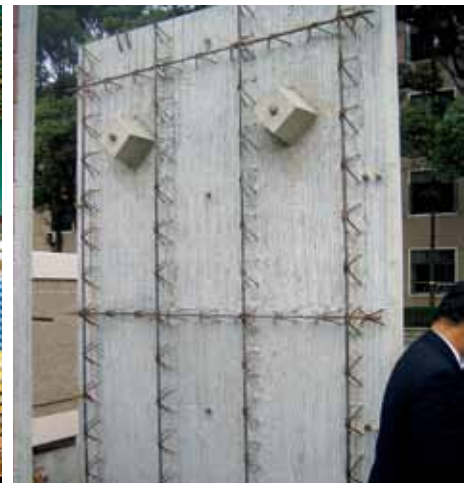
图4 日本构件配筋方式
