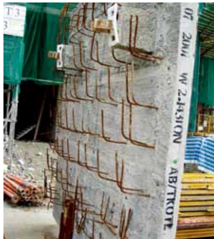
图3 香港构件配筋方式
