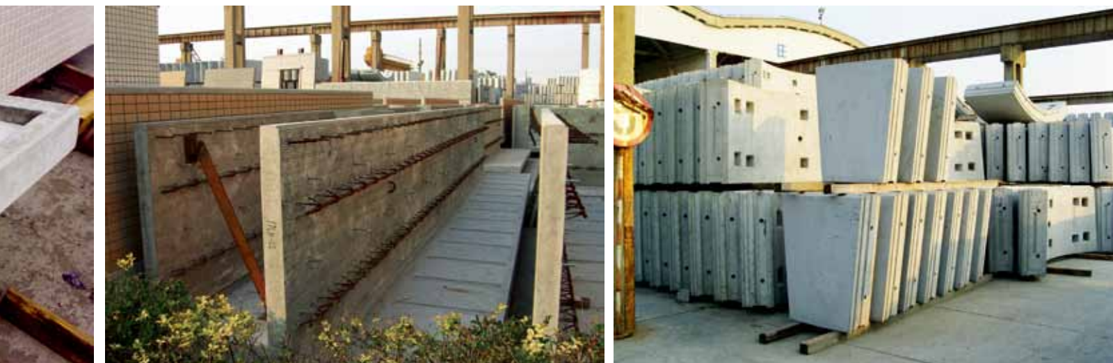
图12 万科金色里程现场施工
