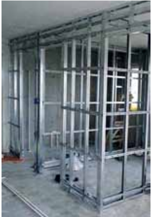
图25 现场实际情况
