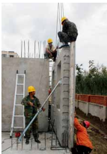
图2 施工中的预制剪力墙结构
