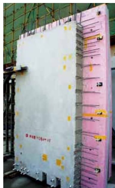
图3 沈阳万科预制夹心保温剪力墙板
