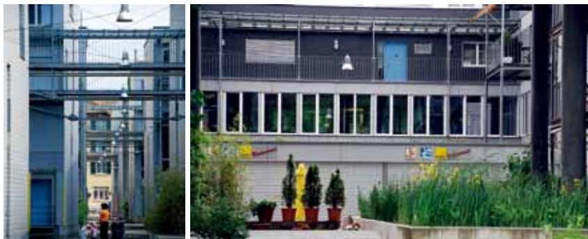
图11 建筑之间的通廊和内院
