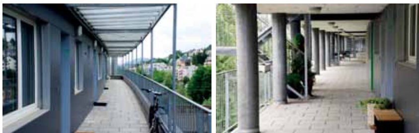
图13 中间层和顶层的通廊
