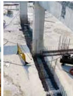
新的墙体结构夹住原始结构
