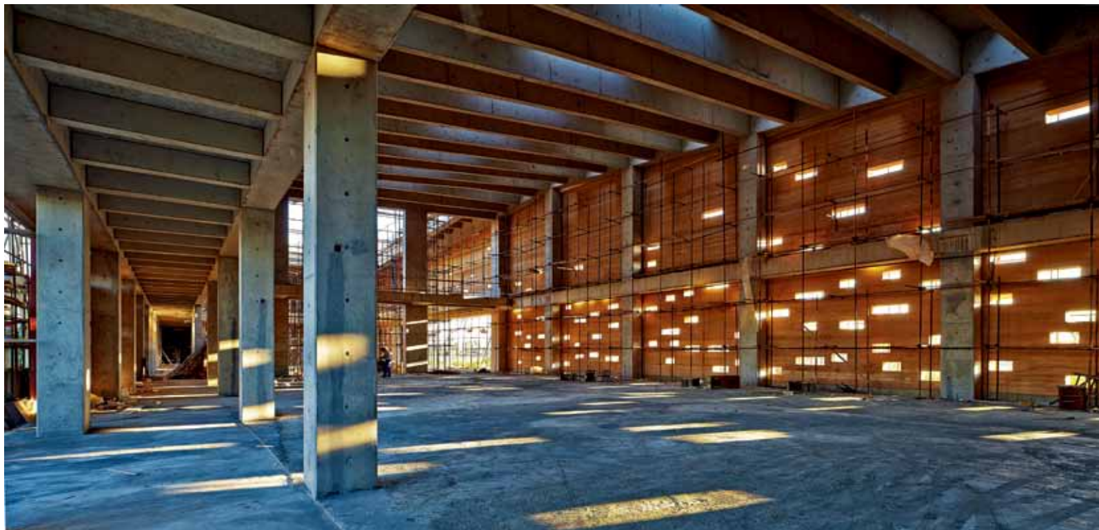
图23 施工中的建筑内部空间
