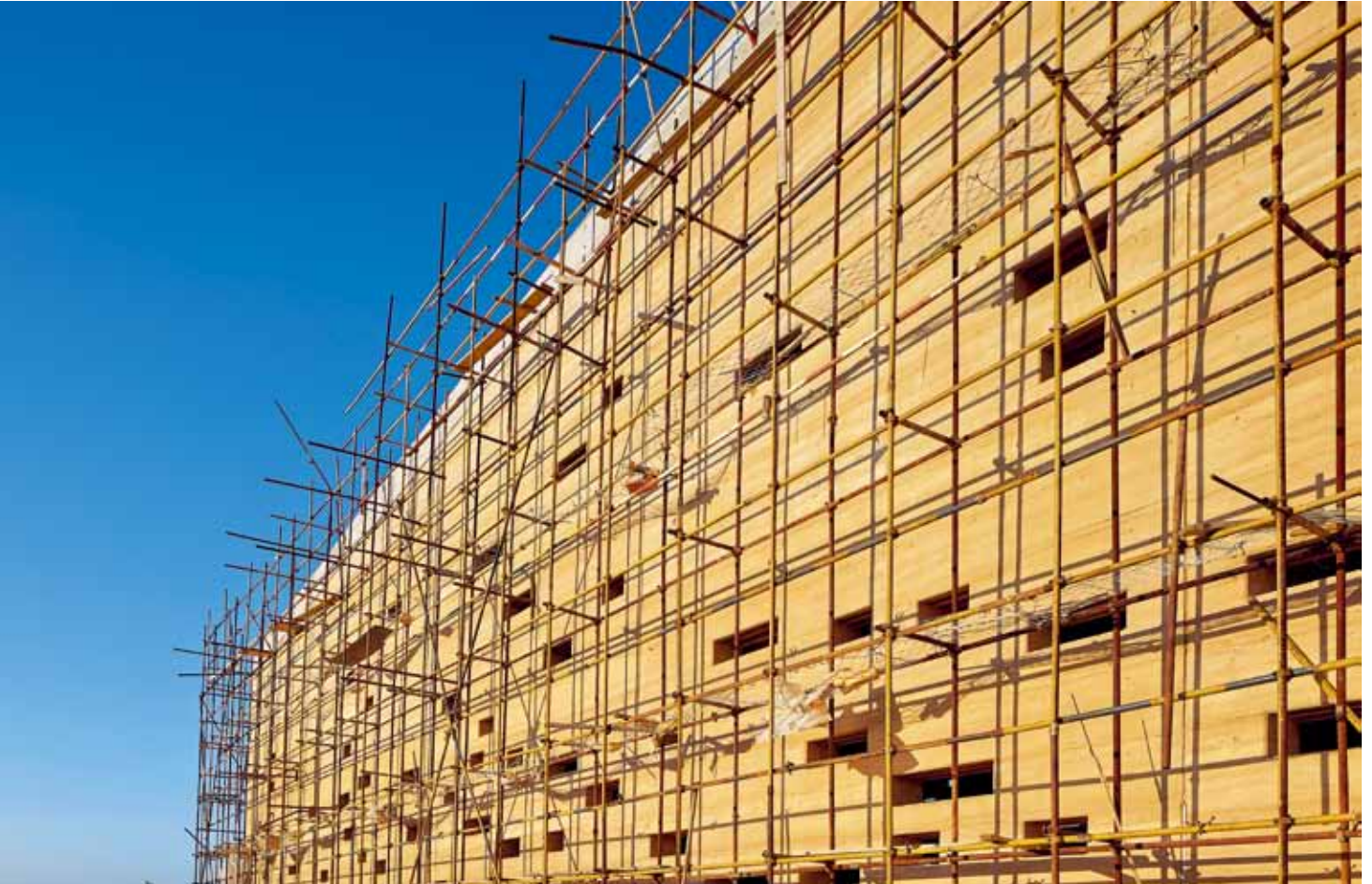
图17 施工中的夯土墙体
