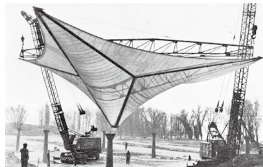
图15 洛桑世博会展亭组装过程
