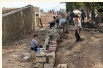
毛石挡土墙砌筑过程
