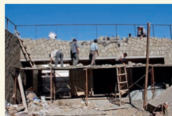
石砌墙面返工
