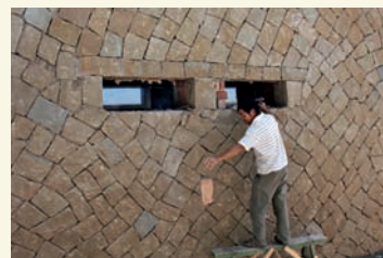
石砌过梁支撑体拆除中
