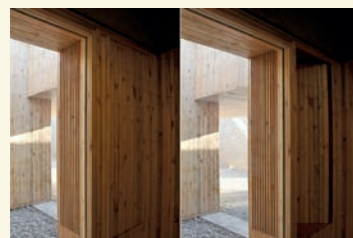
落地窗木质开启扇关闭情况
