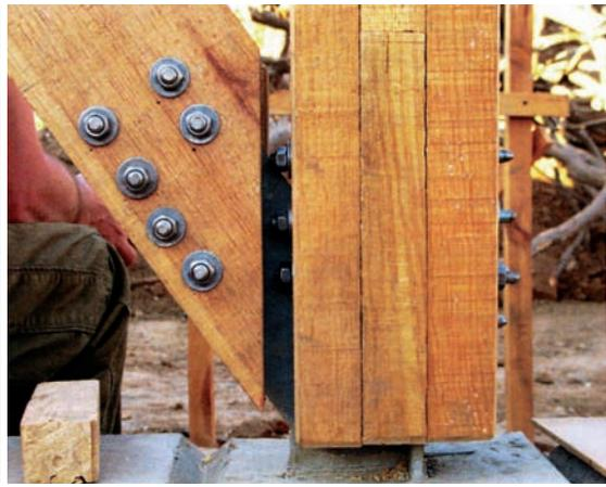
图8 混凝土、钢、木之间的连接逻辑
