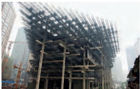
“题凑”土建与钢结构施工
