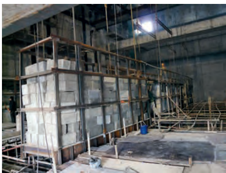
预压加载施工
