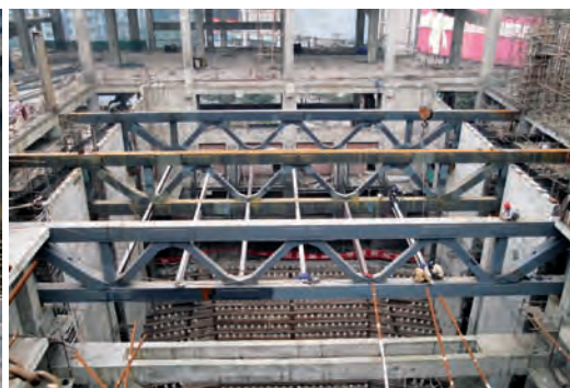
转换桁架施工
