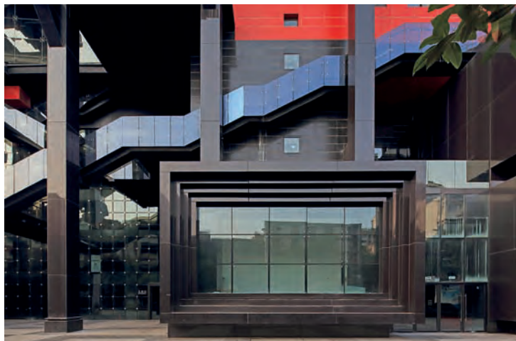
建筑与城市的互动（楼梯、坡道、平台）
