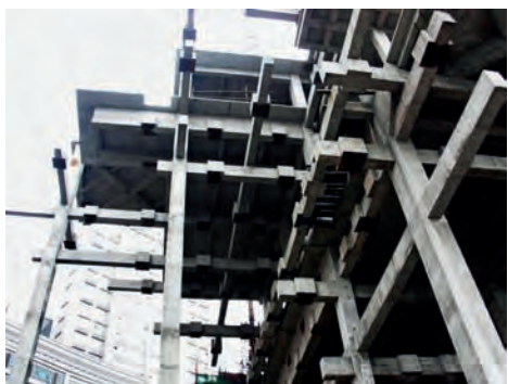
混凝土结构施工
