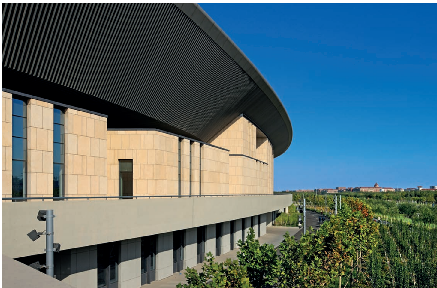
屋檐局部实景
