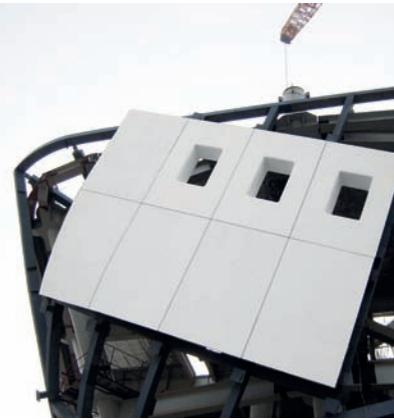
图15 安装接缝
