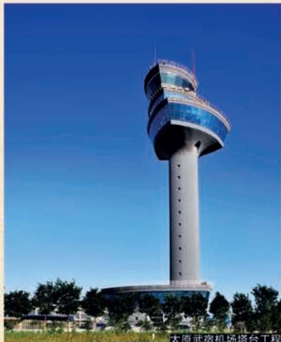
太原武宿机场塔台工程
