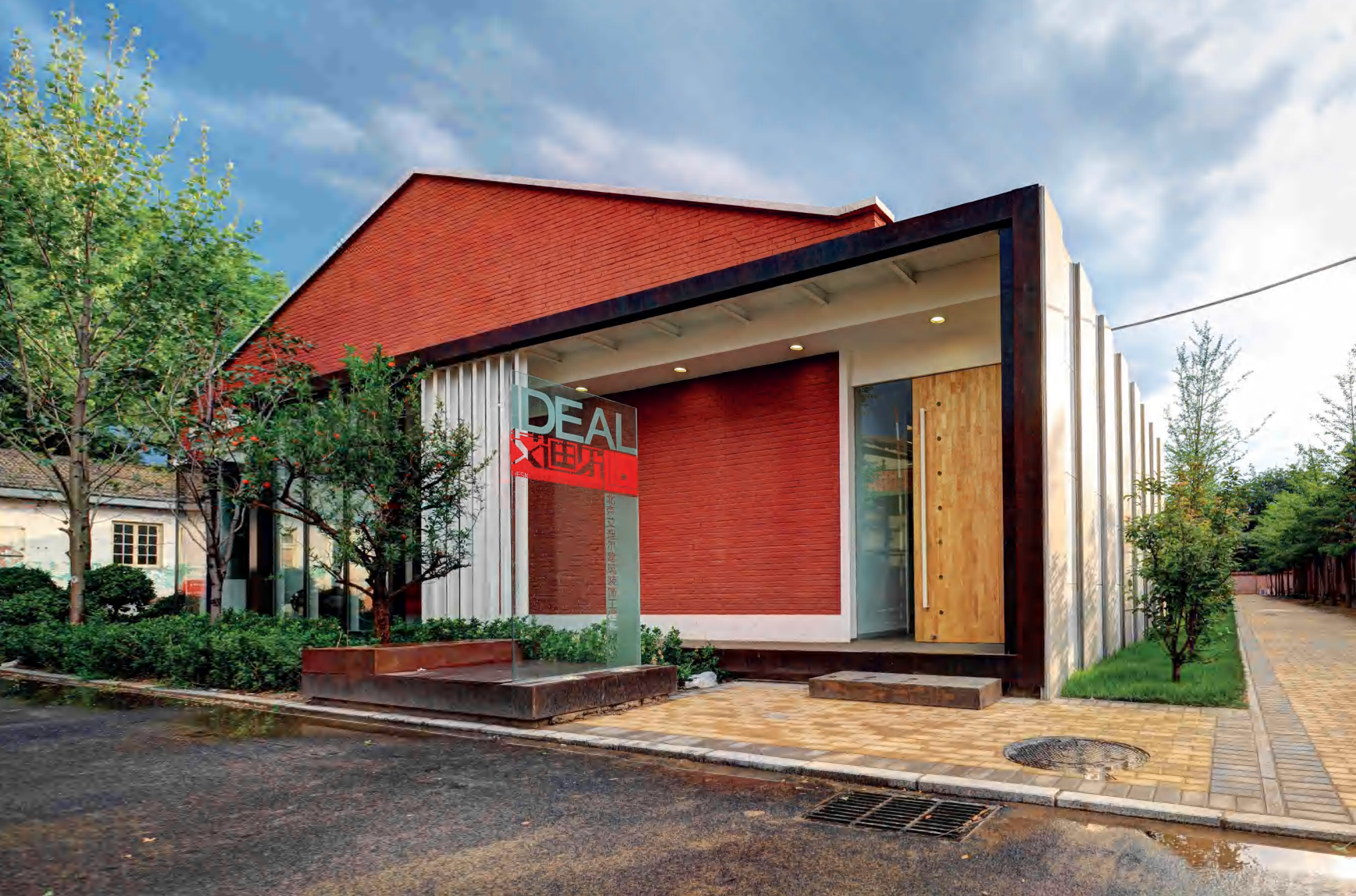
新华1949园区艾迪尔办公楼东立面
