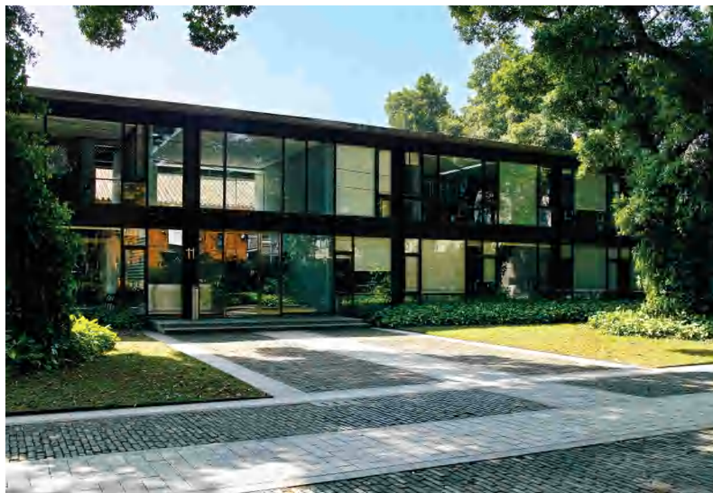
新增钢结构正立面，钢结构、玻璃、红砖等现代与传统材料调和结合
