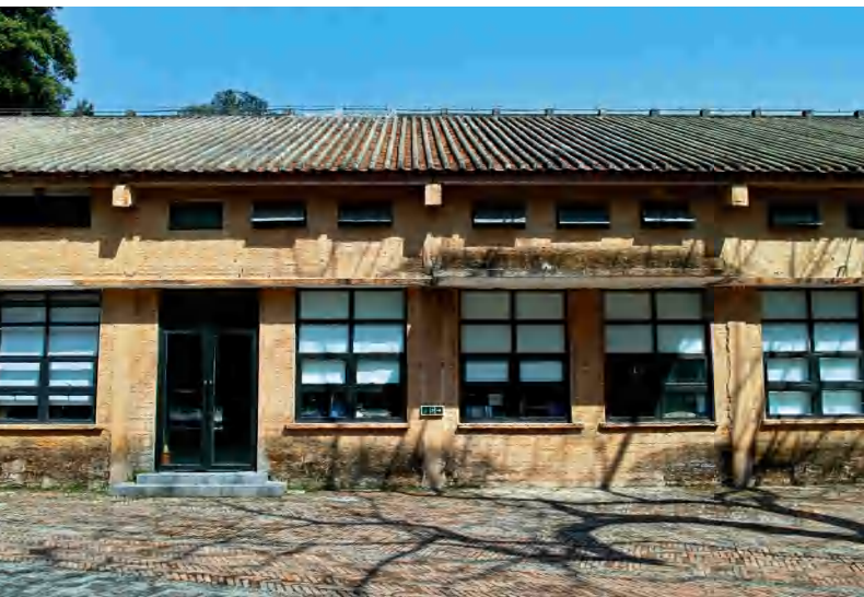
原厂房建筑改造后的背立面，原有建筑基础上增加通透玻璃
