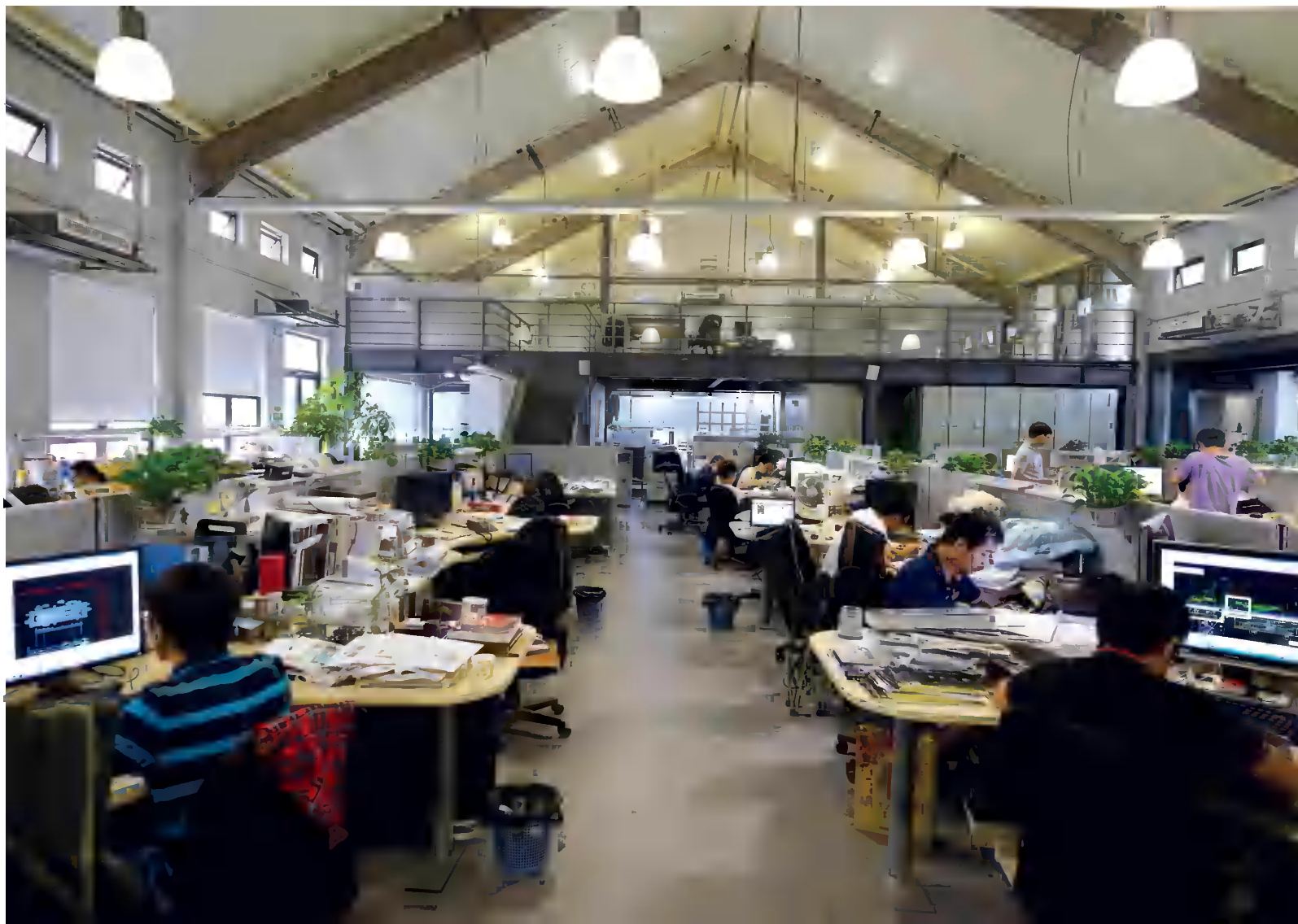
旧厂房大空间被完整保留，满吊彩钢夹心屋面板并加设夹层，作为大办公区
