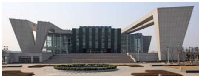
2008奥运射击馆（外墙面积5 400m 2 ）
