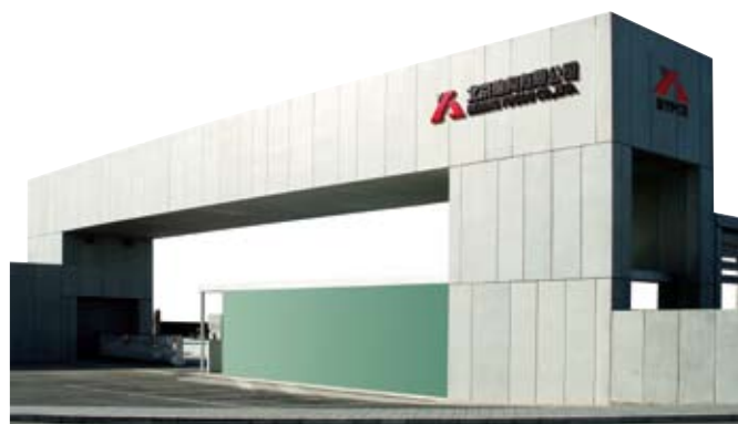
公司生产区大门外饰面为清水混凝土外挂板
