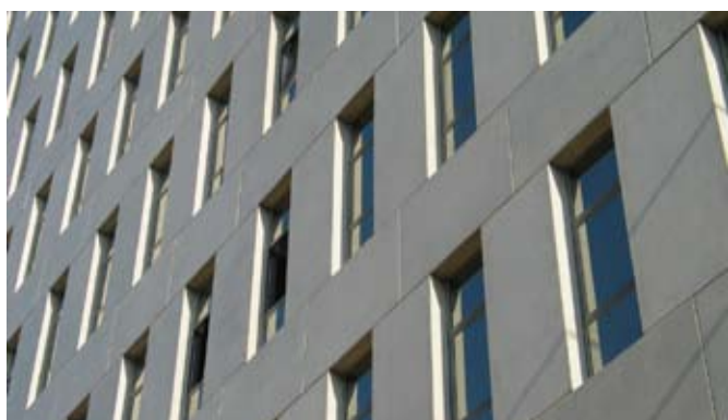
清水混凝土外墙细部
