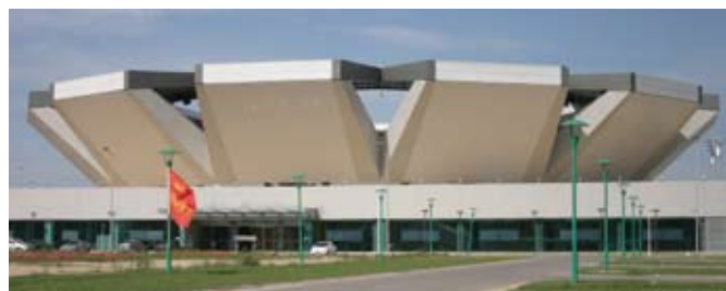
奥林匹克公园网球中心 （外墙面积1 500m 2 地面板面积14 000 m 2 ）
