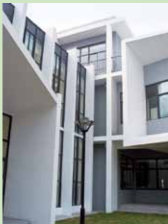
图5 简洁明快的混凝土结构
