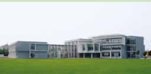
图9 综合教学楼立面实景
