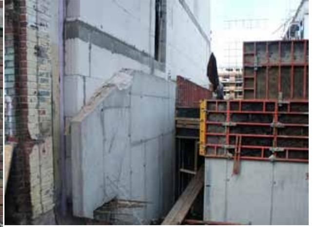
新老墙体的构造及保温维护结构
