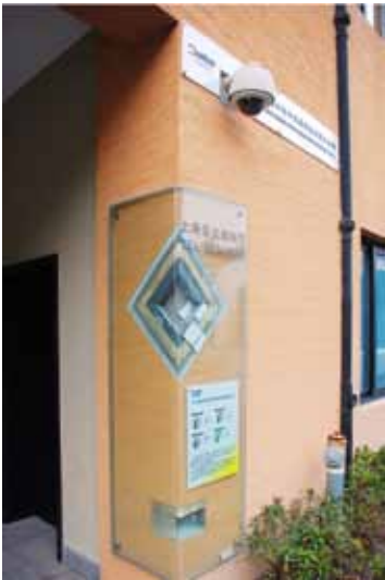
图5 EIFS外保温构造
