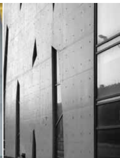
清水混凝土墙面细部
