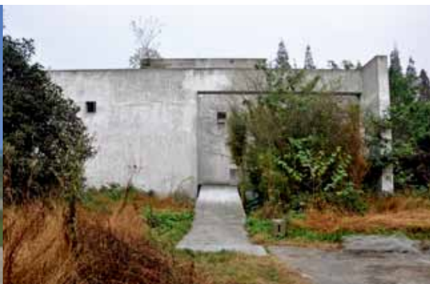
建筑现状(作者拍摄 )
