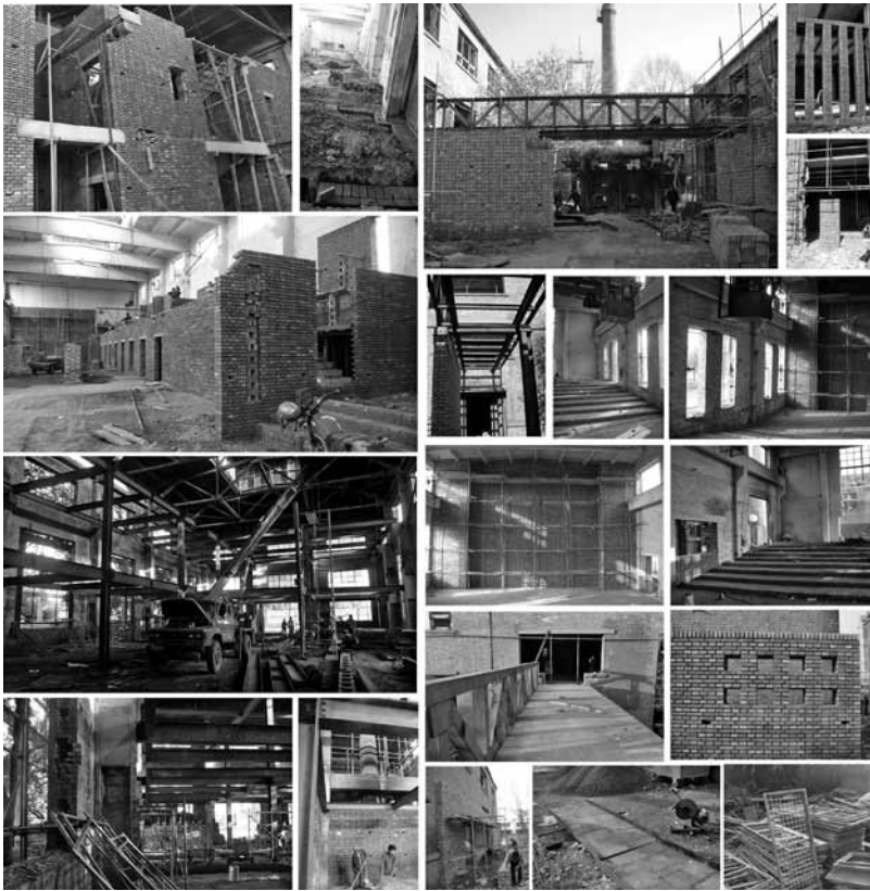
图2 改造施工过程
