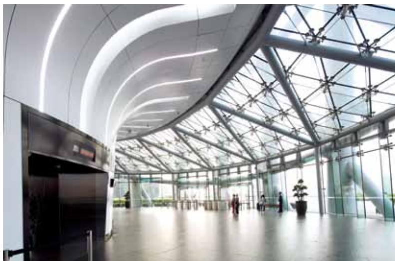
图9 7.2m层大厅幕墙局部
