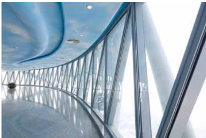
图6 观景大厅室内幕墙局部
