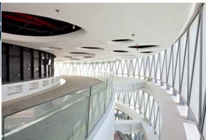
图7 旋转餐厅室内幕墙局部
