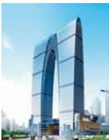
华东院资深总工程师汪大绥介绍说，世界上有很多类似于门或者叫做门的建筑，其中最有名的是巴黎凯旋门，高度是49m，宽度也是40多m，但是门的跨度不到15m。巴黎新区拉德方斯新凯旋门高度是100m。上海也有一个上海凯旋门大厦，由华东院设计，高度是30层，110m左右。东方之门采取了高于国家规范的抗震设计标准。苏州的地震裂度要求是6度，但是东方之门按照7度采取抗震措施。东方之门前面有一个裙房，裙房的顶部有一座大跨度的天桥，这是东方之门建筑造型的特色之一。在天桥的设计当中充分考虑了抗震、抗风的特殊要求，采用了进口的减震设施。因为桥比较高，比较空旷，为了保证大楼的安全和质量，对很多关键性的节点进行了实验研究和分析，确保它既是一个建筑精品，也是一个结构精品。
