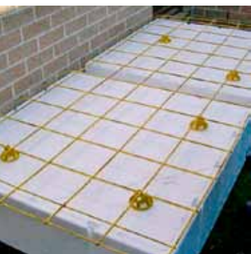
保温夹心水泥地板聚苯乙烯保温块
