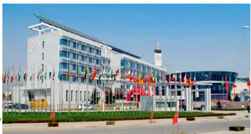
图20 实验主楼建筑外观
