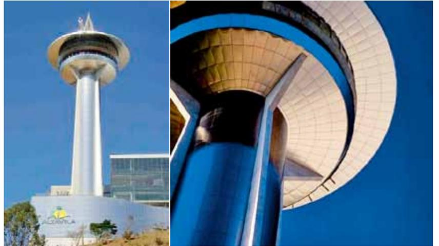
图6 位于贝洛奥里藏特的阿尔塔维拉塔（塔面为不锈钢，使用70t 抛光304钢）
