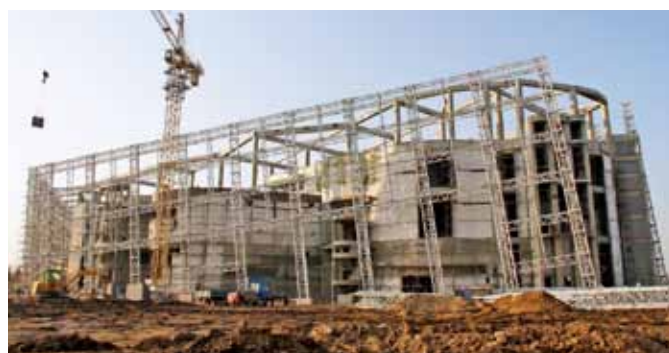
正在施工中的河北园博会主展馆
