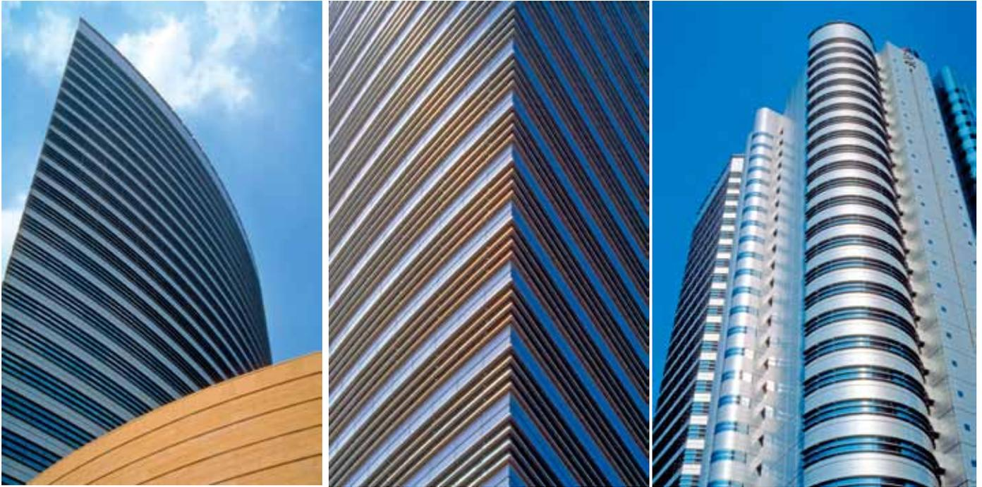
一些限制要求决定了建筑的平面布局和弧线三角形形体：公共开放区，场地南面的高架公路，两个走廊，以及安置传输设备和屋顶直升机停机坪。除此之外，日照要求也决定了塔楼的形状，即塔楼给相邻住宅造成的阴影一天不能超过3小时。塔楼高度限制为127m。
