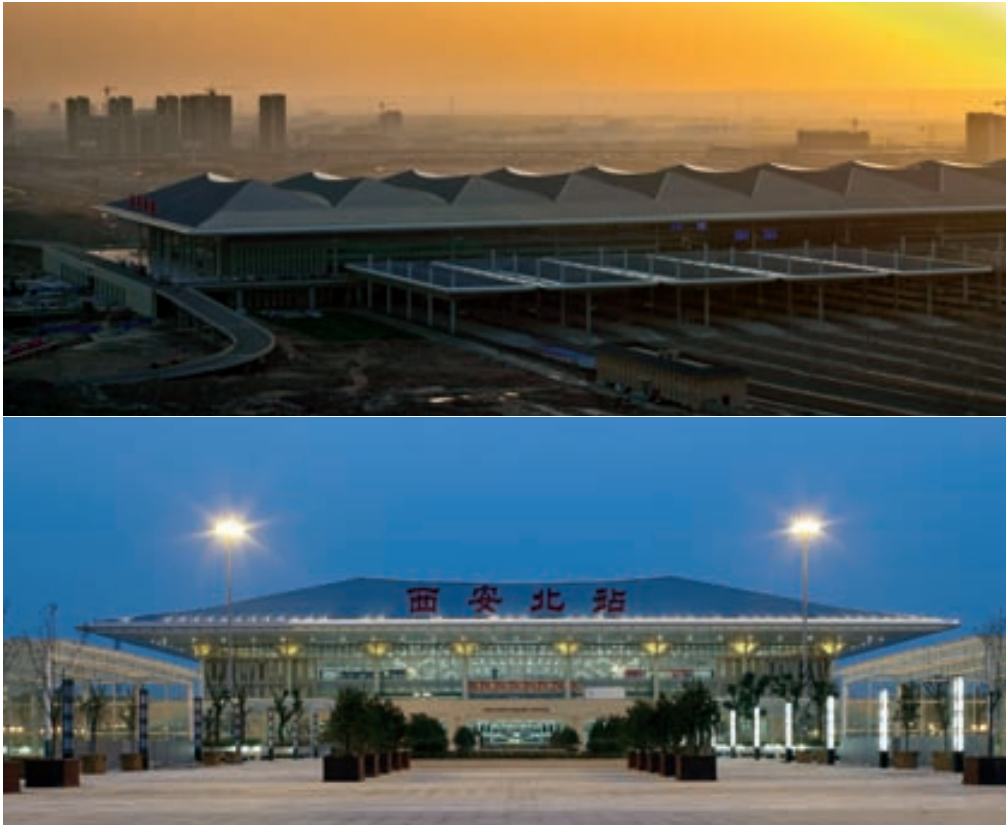
高铁西安北站
