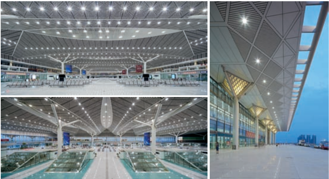
高铁西安北站
