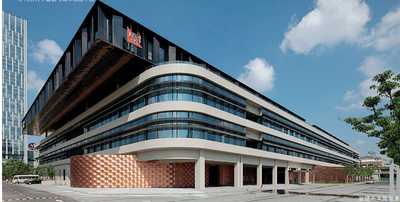
新楼西南角实景
