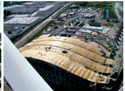
速滑馆是由 2 400m<sup>3</sup> 的云杉 - 松木 - 冷杉规格材（用于波浪木屋面板）、19 000 张 1.2m × 2.4m 花旗松胶合板（主要用于屋面）和 2 400m<sup>3</sup> 花旗松胶合梁（用于屋面拱），结合 70m<sup>3</sup> 黄柏胶合木柱（用于室外支撑柱）构成。速滑馆底部两层是现浇混凝土，屋盖由 100m 跨度的钢 - 胶合木复合拱支撑在巨大的斜向混凝土支墩上，钢木复合拱的截面为空心“V”形，“V”形的尖部为刃形钢件，以连接两边腹板位置的两片胶合木拱梁。胶合木拱顶部为 H 型钢，型钢在水平向有横向支撑连接，该 H 型钢在接近拱支座时升起以支承翘起的屋檐。钢 - 胶合木复合拱的空心结构为管线的铺设提供了空间，拱身上可以看到有空调系统的出风口。
