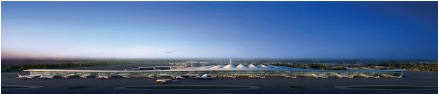
禄口国际机场T2航站楼空侧鸟瞰图（效果图，在建）
