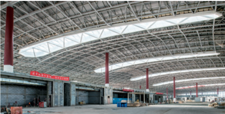
T2航站楼室内实景照片(钢屋架完成、吊顶未施工)
