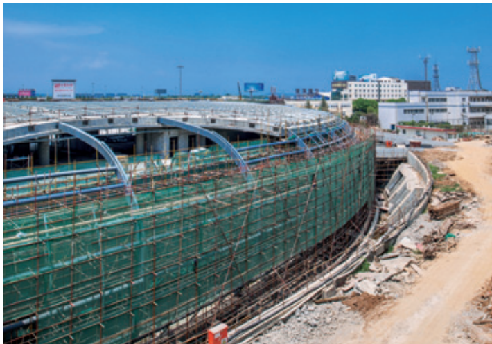
停车楼弧形外墙（在建）
