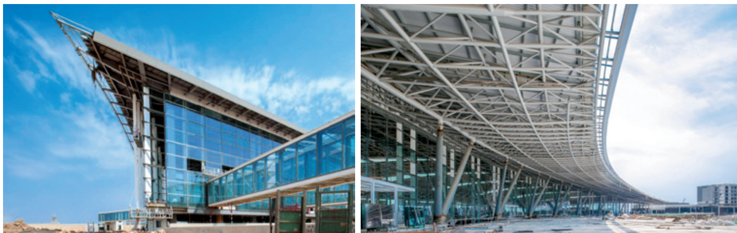
T2航站楼大挑檐实景图（施工阶段）
