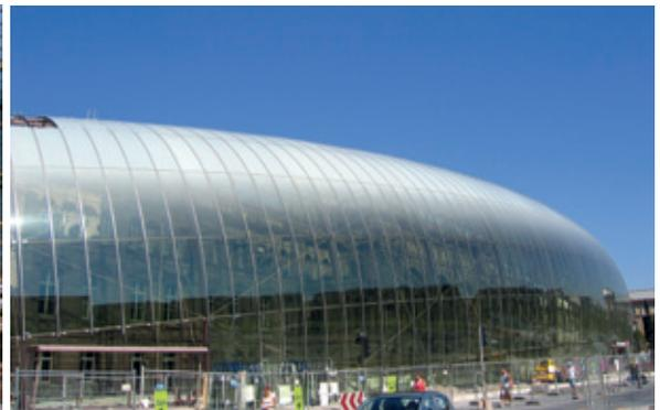
图10 斯特拉施堡高铁车站-冷弯玻璃外观
