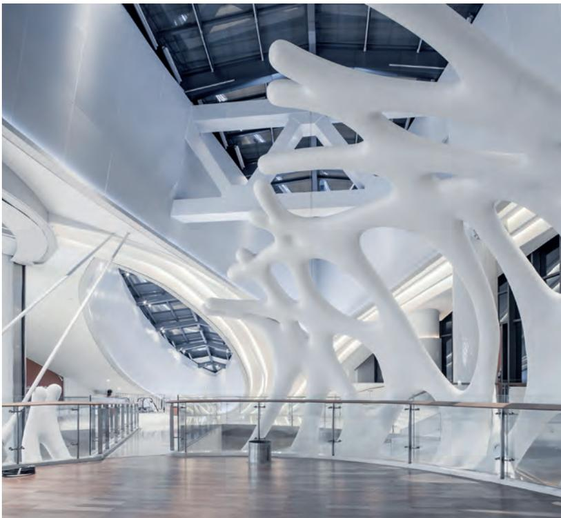
护结构和使用者的距离很近，如果采用大尺度的策略则近距离视觉效果太粗糙；如果采用小尺度的方法，其造价方面可能难以承受。经过分析，我们提出了两者结合的技术策略，即在近人界面采用高精度加工的构件，在不影响体验的结构部分则放松构造精度要求，降低造价。
