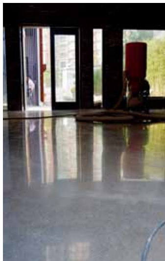
原作设计工作室多功能区地坪浇筑和抛光过程
