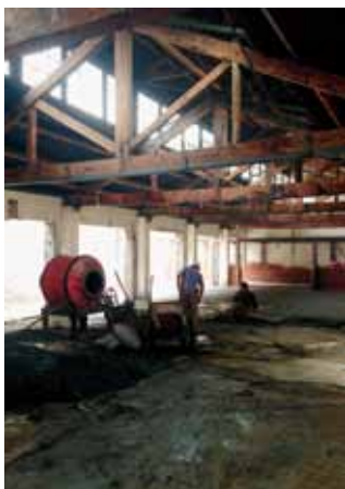
原作设计工作室工作区混凝土地坪浇筑和抛光过程
