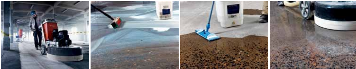
施工步骤：研磨—修补—固化—抛光
