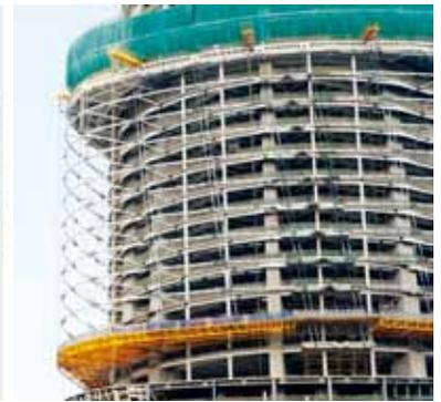
图22 悬挂式幕墙支撑结构（施工中）
