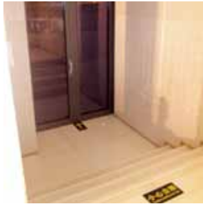
图12 国家话剧院紧急疏散口
