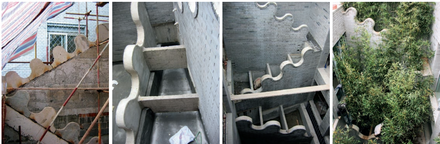
云墙施工过程
