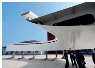
造船钢板幕墙样板
