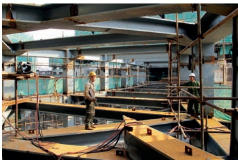
连桥施工过程
