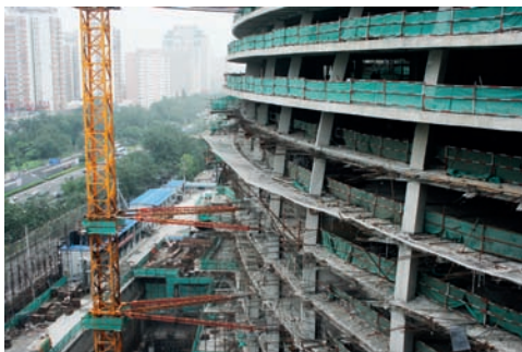
建造中的银河SOHO外圈倾斜柱
