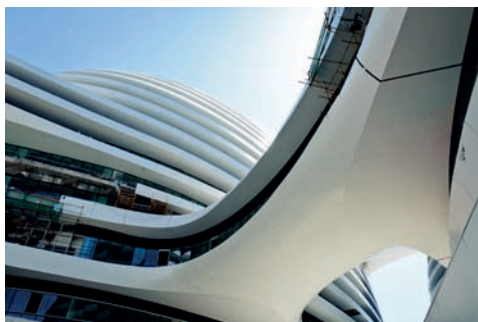
接近完工的连桥
