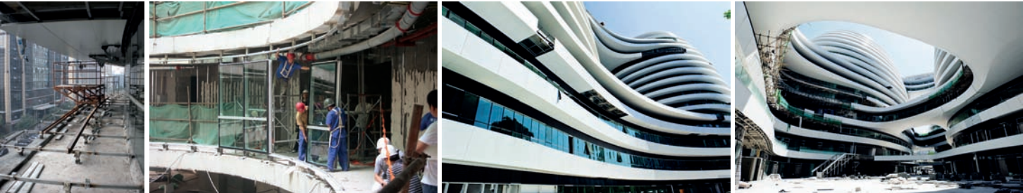
幕墙的施工安装
